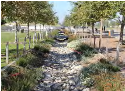
Bioretention Swales
